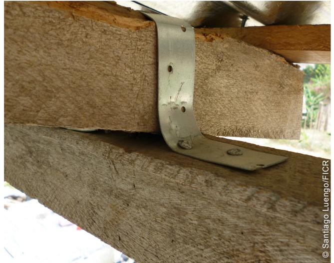
La Organización B introdujo en Cuba la nueva tecnología de las cintas de refuerzo metálicas contra los huracanes. Debido a que las cintas no siempre se plegaban correctamente, se organizaron sesiones de capacitación e inspecciones de las obras para reducir la aplicación incorrecta.
